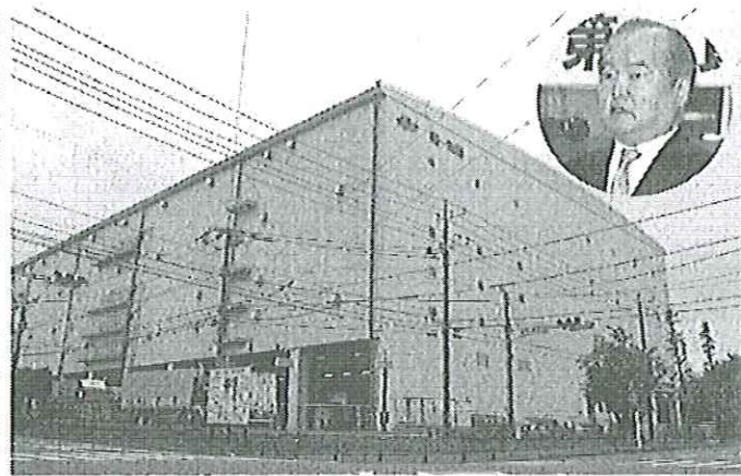
完成した新厚木支店(厚木ターミナル)と竣工式であいさつする武藤社長
